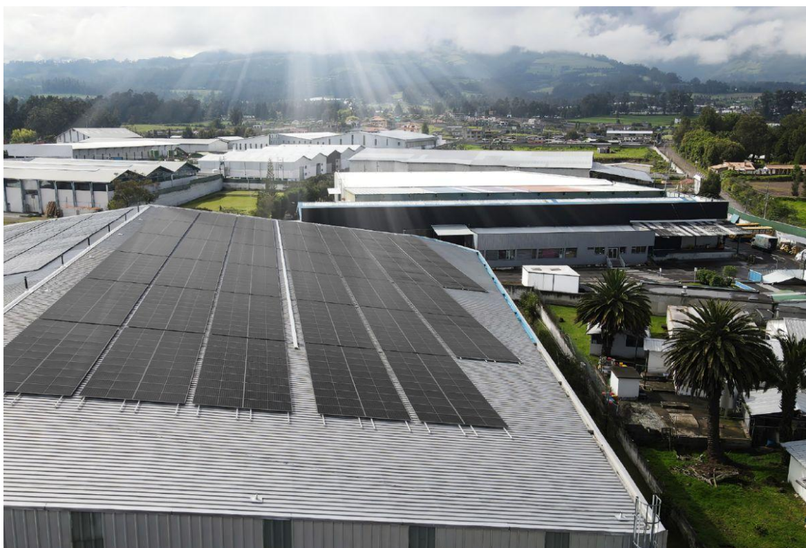
Figura 20. Paneles solares. Elaboración propia
